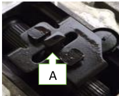
〈写真〉GSUとミッション接続部
